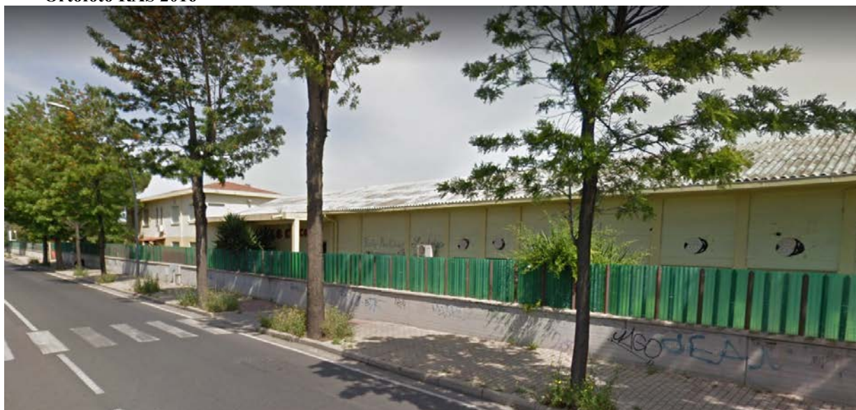
Vista da sud - Via Trieste
