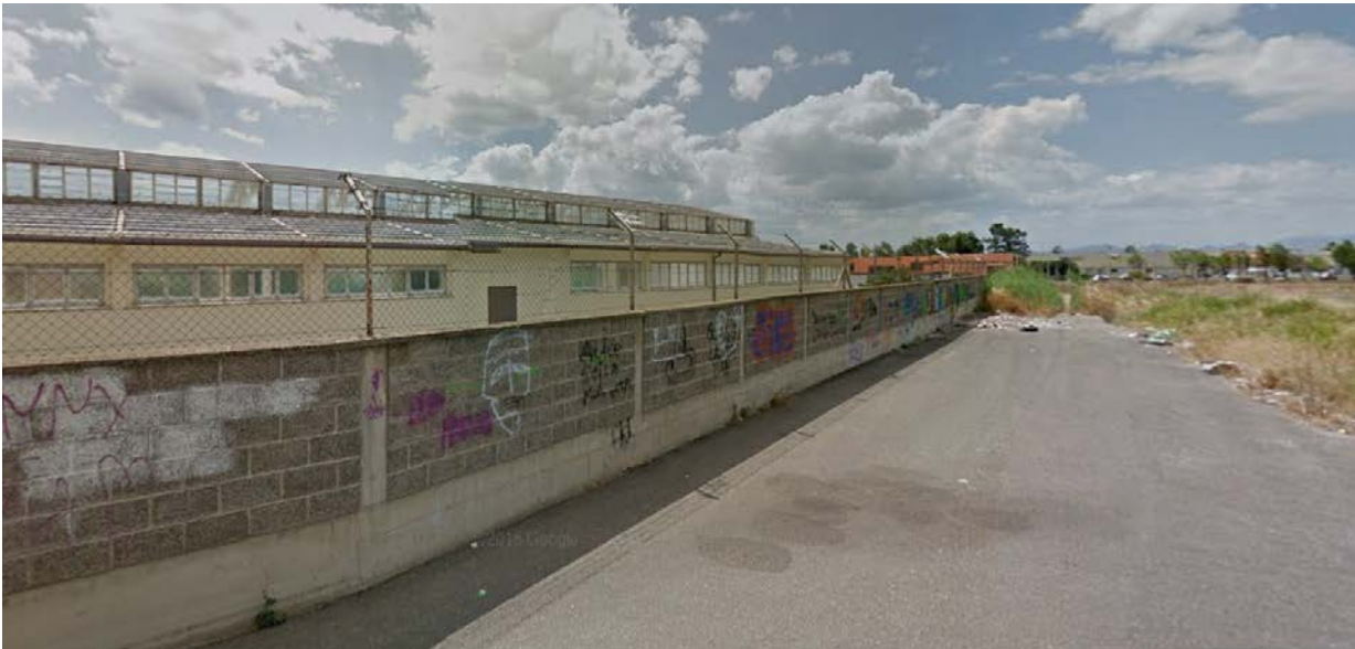
Vista da nord - Via Crispi
